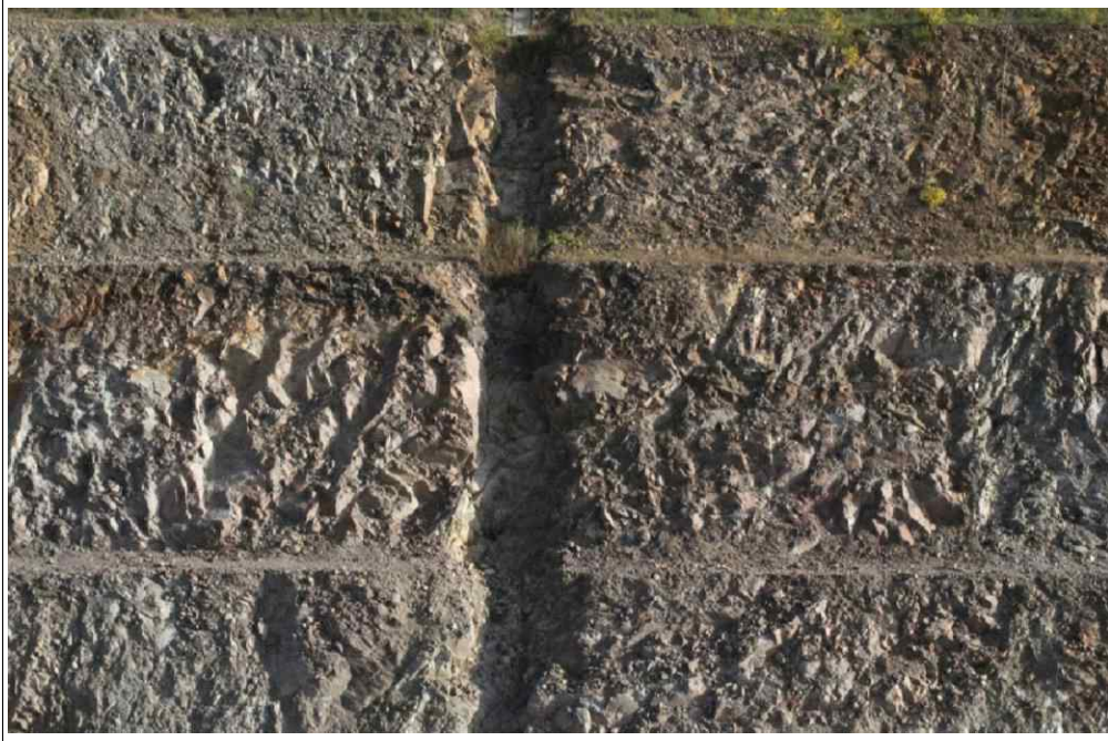
【그림 15】 B 영역 종배수구 시공사진(STA.4+810)
