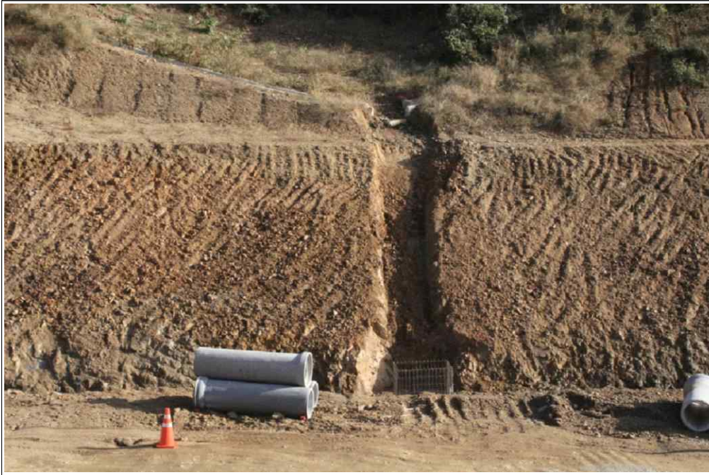
【그림 5】 STA.4+680 계곡부 및 종배수구 전경사진
