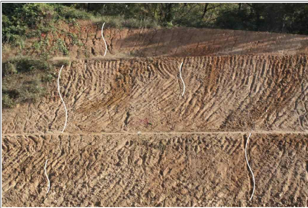
【그림 24】 D 영역에 발달한 불연속면
