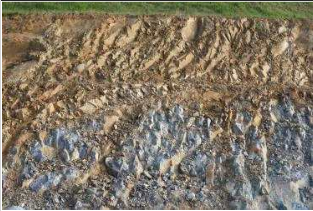
【그림 20】 C 영역에 발달한 불연속면 상세사진
