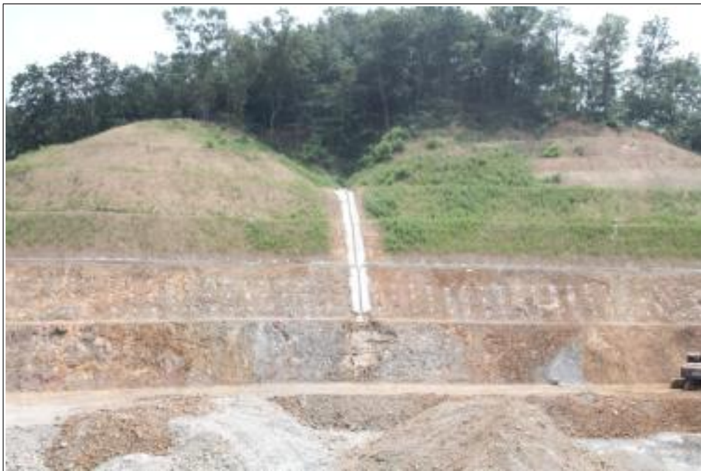
【그림 8】 비탈면 보강(Soil Nailing)사진(2)
