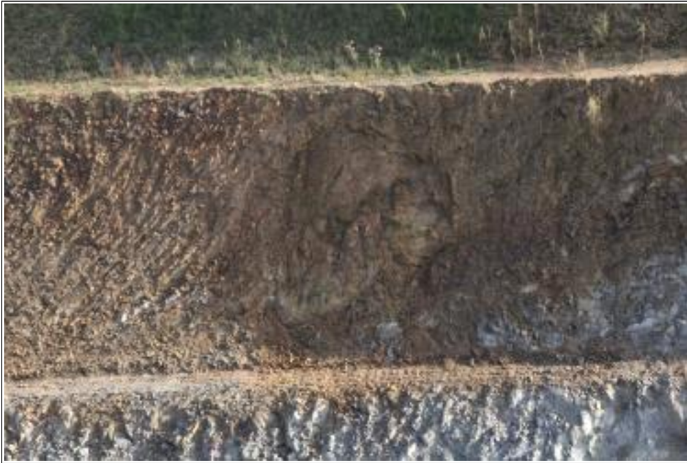
【그림 12】 A 영역 상세사진 (세편화된 암석)
