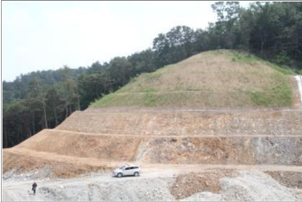
【그림 7】 비탈면 보강(Soil Nailing)사진(1)
